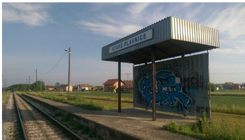
Slika 5.12. Stajalište Stare Plavnice
