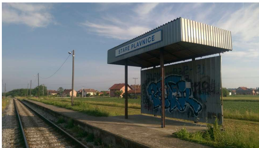
Slika 5.12. Stajalište Stare Plavnice
