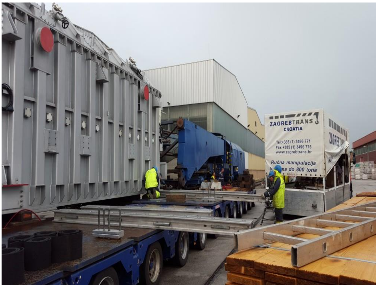
Slika 12 Ukrcaj transformatora na poluprikolicu
