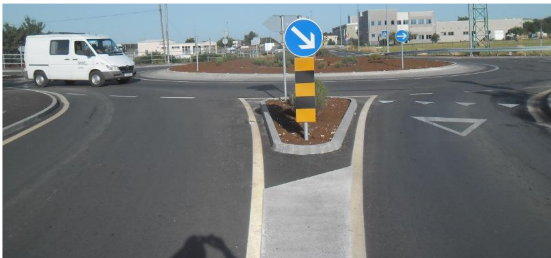
Slika 5. Razdjelni otok unutar površine za razdvajanje prometa, [3]
