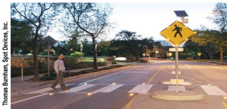
Slika 22. Obilježavanje pješačkog prijelaza sa nestandardnim znakom i LED prometnim svjetlima [5]
