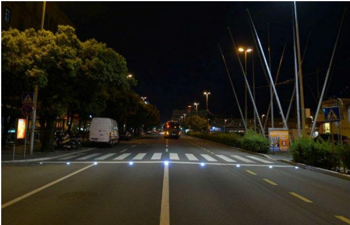
Slika 20. Osvjetljenje pješačkog prijelaza [5]
