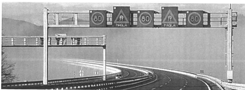
Slika 9. Primjer VMS-a na autocesti u Republici Hrvatskoj koji daje informacije o meteorološkim uvjetima i ograničenju brzine ovisnom o uvjetima, [20]
