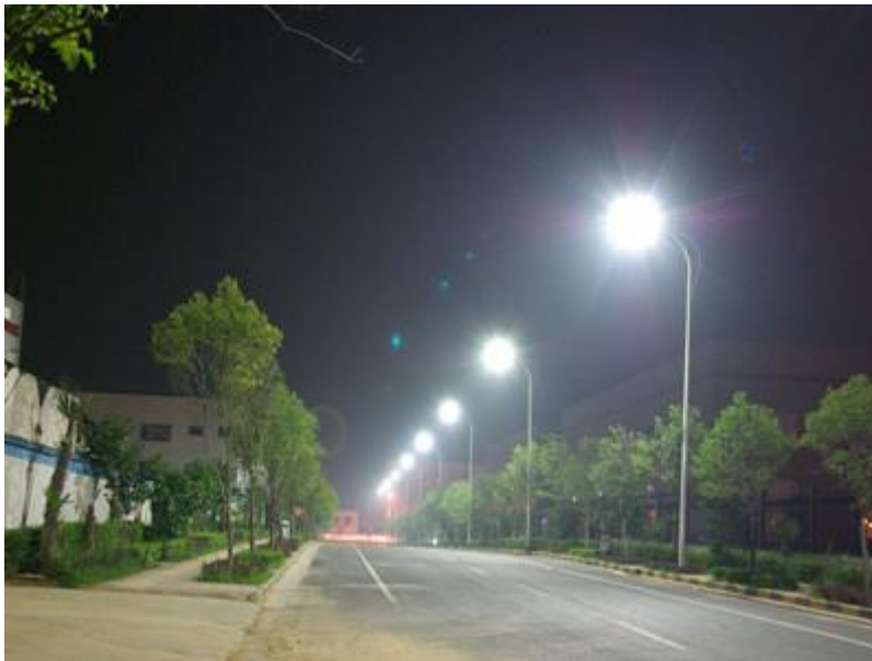
Slika 17. - Jednostrani raspored izvora svjetlosti
