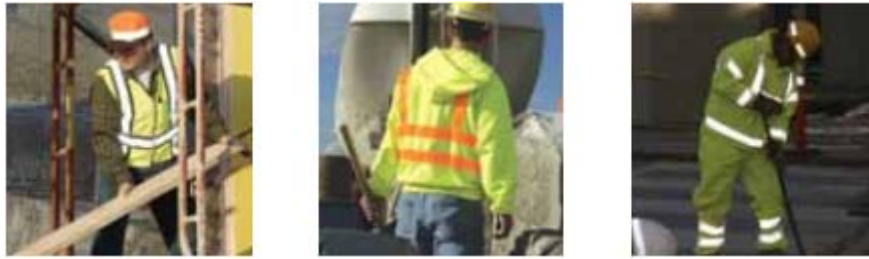
Slika 2. Tri razreda zaštitne odjeće s visokom vidljivošću prema ANSI/ISEA 107-2010: razred 1 (lijevo), razred 2 (sredina), razred 3 (desno)
