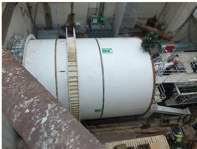
Slika 27: Izgradnja linije B (na slici prikaz uređaja za tuneliranje (engl. boring machine) u gradu Rennes
