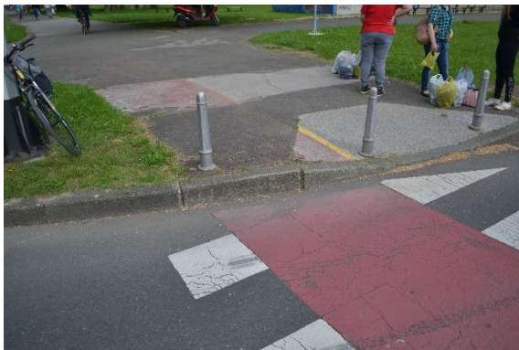
Slika 17. Nepravilno postavljen rubnjak
