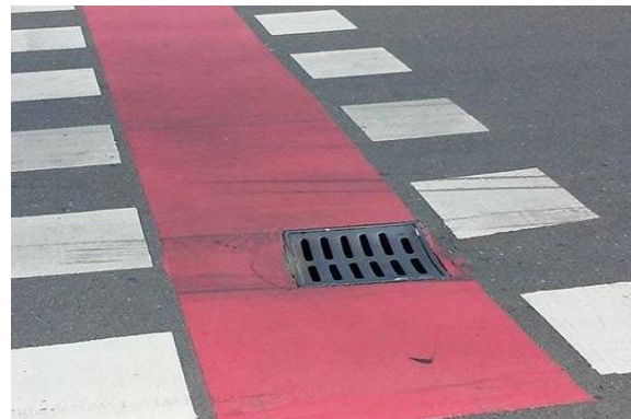
Slika 18. Nepropisno postavljene slivne rešetke na Aveniji Dubrovnik
