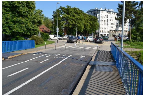
Slika 31. Savski most (južni prilaz)
