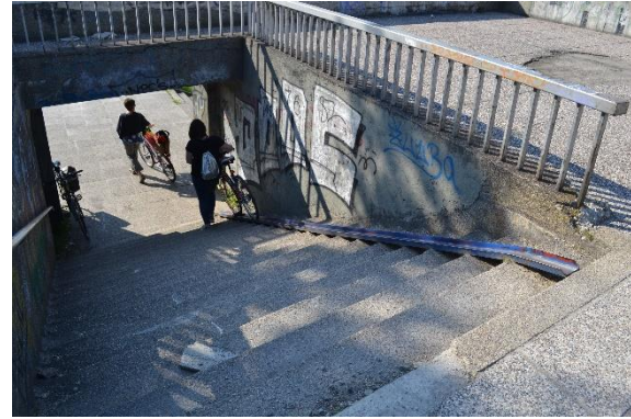
Slika 38. Kanalice na stepenicama na Mostu mladosti nasip
