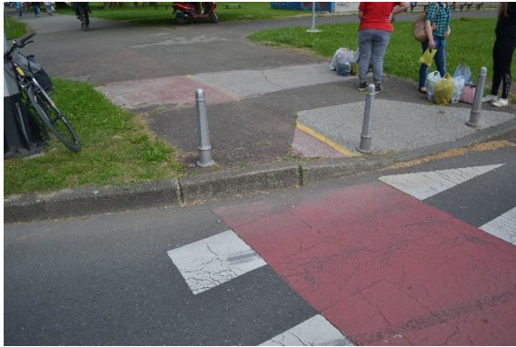
Slika 17. Nepravilno postavljen rubnjak
