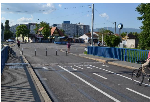
Slika 30. Savski most (sjeverni prilaz)
