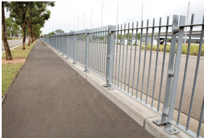
Slika 44. Pješačka ograda uz kolnik, [34].
