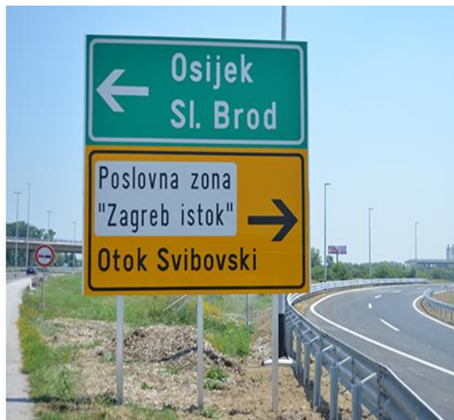
Slika 36. Primjer postavljanja prometnog znaka na lijevoj strani kolnika,[31]
