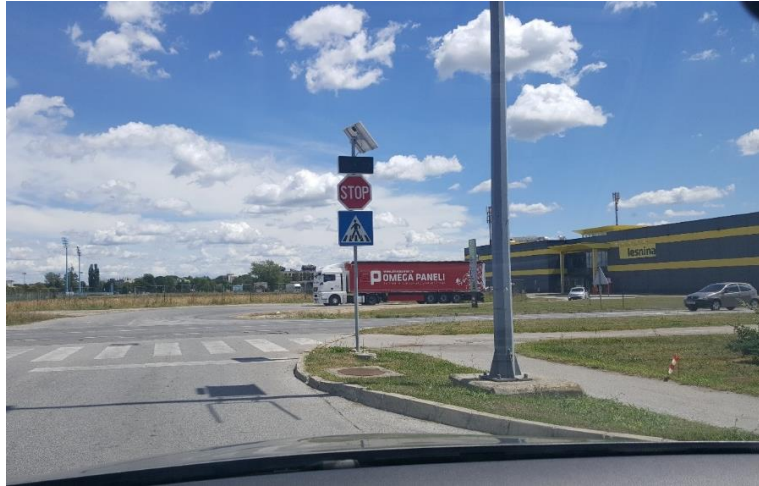
Slika 58: Prometni znak opremljen dodatnim treptačima
