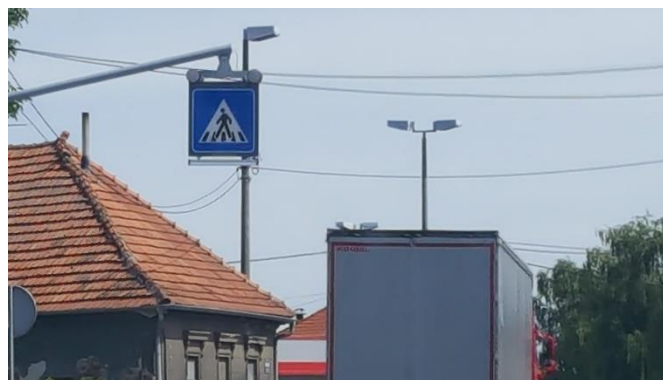
Slika 59. Način obilježavanja pješačkih prijelaza primjenom treptača
