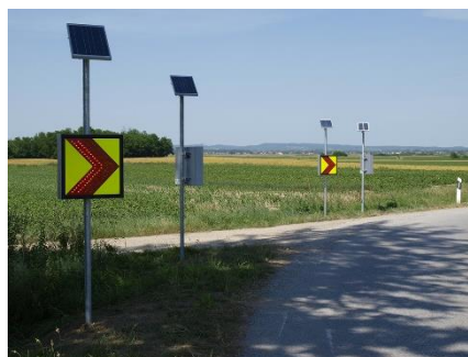
Slika 60. Prometni znak za označavanje opasnog zavoja na cesti izrađen u LED tehnologiji
