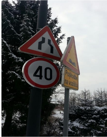
Slika 33. Nepravilno postavljeni prometni znak, [26]
