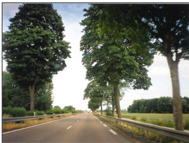
Slika 41. Odbojna zaštitna ograda ispred drvoreda
