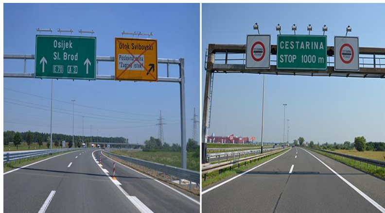
Slika 35. Postavljanje prometnog znaka iznad kolnika, [31]
