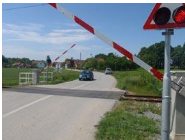
Slika 30. Način obilježavanja prijelaz preko željezničke pruge sa svjetlosnim znakovima, [15]
