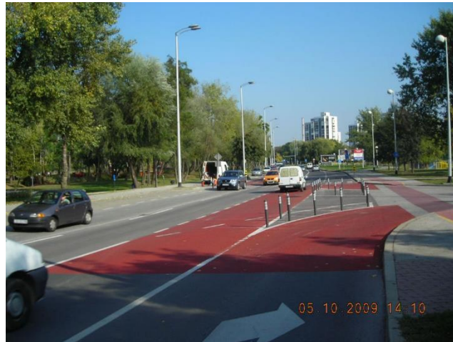
Slika 63. Protuklizne prometne površine, [43]
