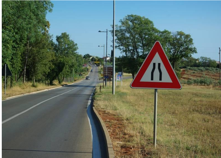
Slika 34. Prometni znak na desnoj strani kolnika, [31]
