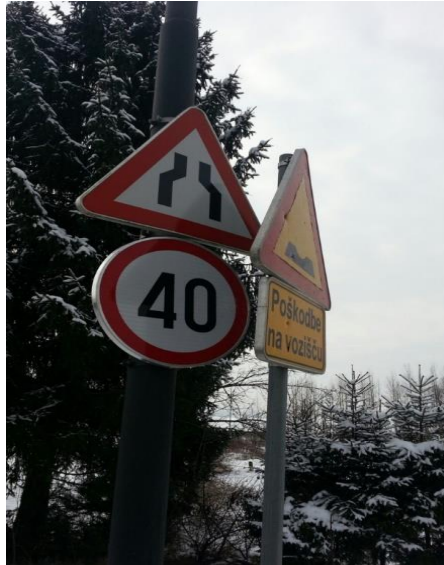
Slika 33. Nepravilno postavljeni prometni znak, [26]
