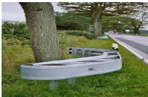
Slika 40. Odbojna zaštitna ograda ispred objekta na cesti
