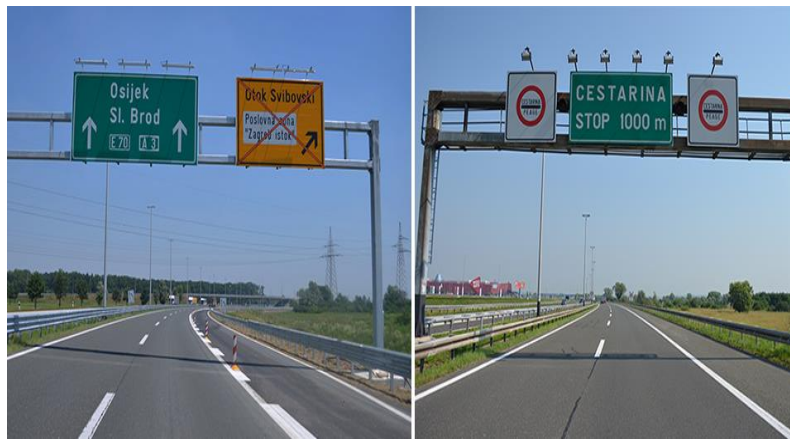
Slika 35. Postavljanje prometnog znaka iznad kolnika, [31]
