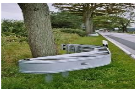
Slika 40. Odbojna zaštitna ograda ispred objekta na cesti
