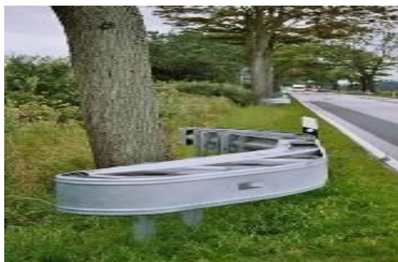
Slika 40. Odbojna zaštitna ograda ispred objekta na cesti
