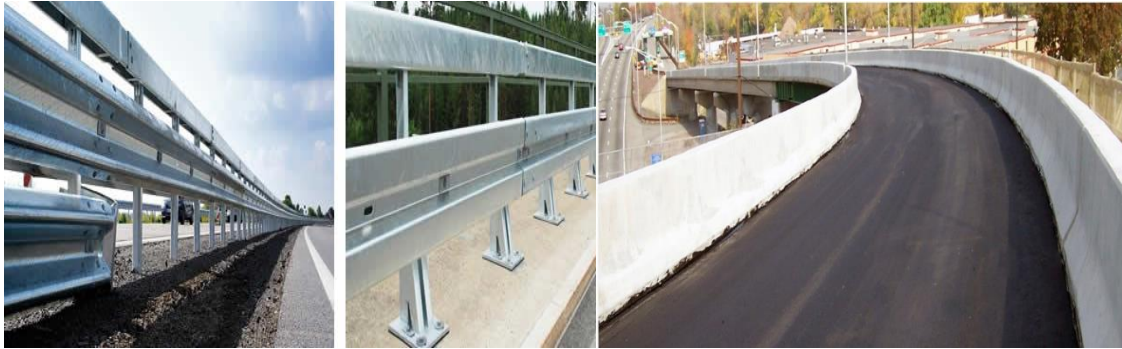
Slika 24. Zaštitne odbojne ograde [23]
