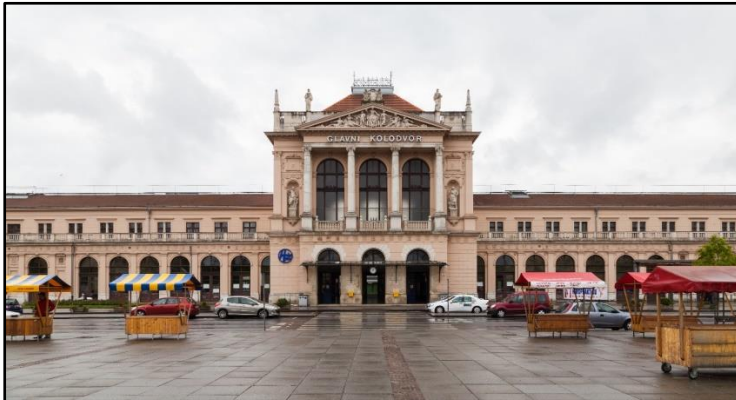
Slika 22. Zagrebački Glavni kolodvor
