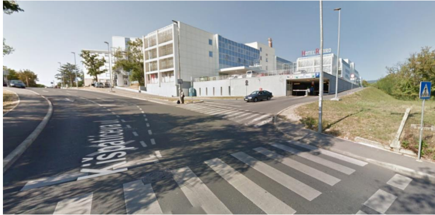
Slika 23.: Ulaz/Izlaz garaža Rebro; [16] www.google.hr/maps
