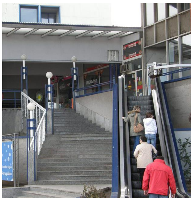
Slika 3.13. Ulaz sa sjeverne strane u AKZ, [6]
