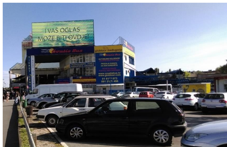
Slika 6.7. Videomonitor na sjevernom pročelju AKZ-a
