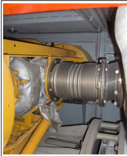
Slika 19. Spoj ispuha motora na ispušni lonac
