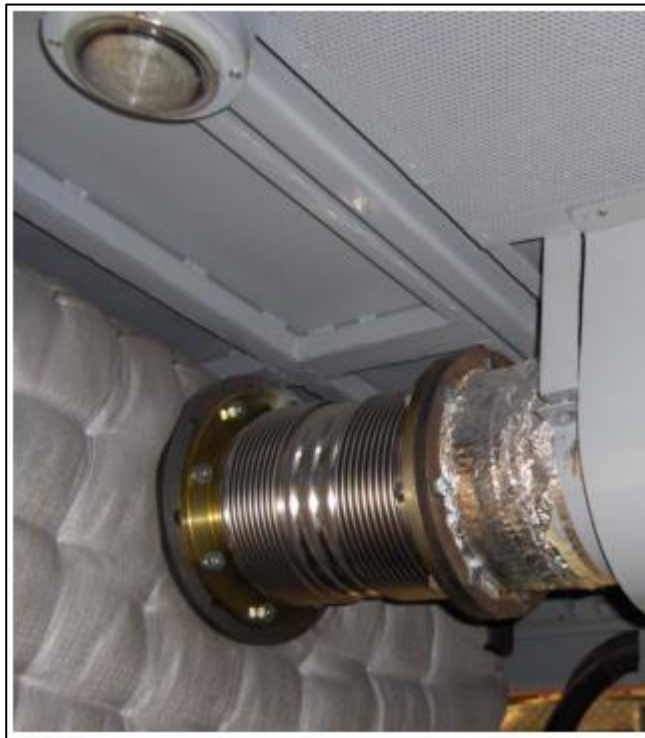
Slika 20. Ispušni lonac sa spojem na ispušnu granu
