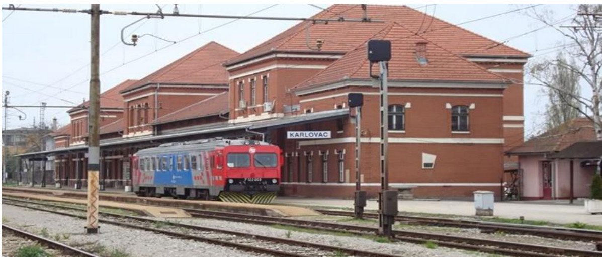
Slika 26. Željeznički kolodvor Karlovac [49]
