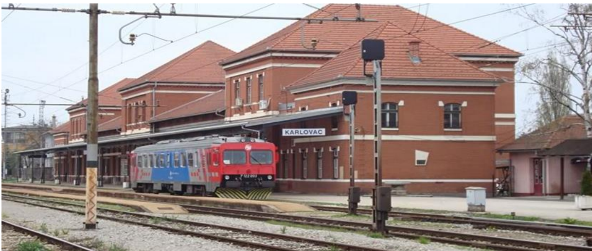
Slika 26. Željeznički kolodvor Karlovac [49]
