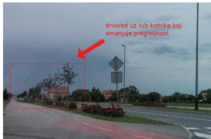
Slika 74. Preglednost prilikom dolaska na raskrižje iz smjera istoka
