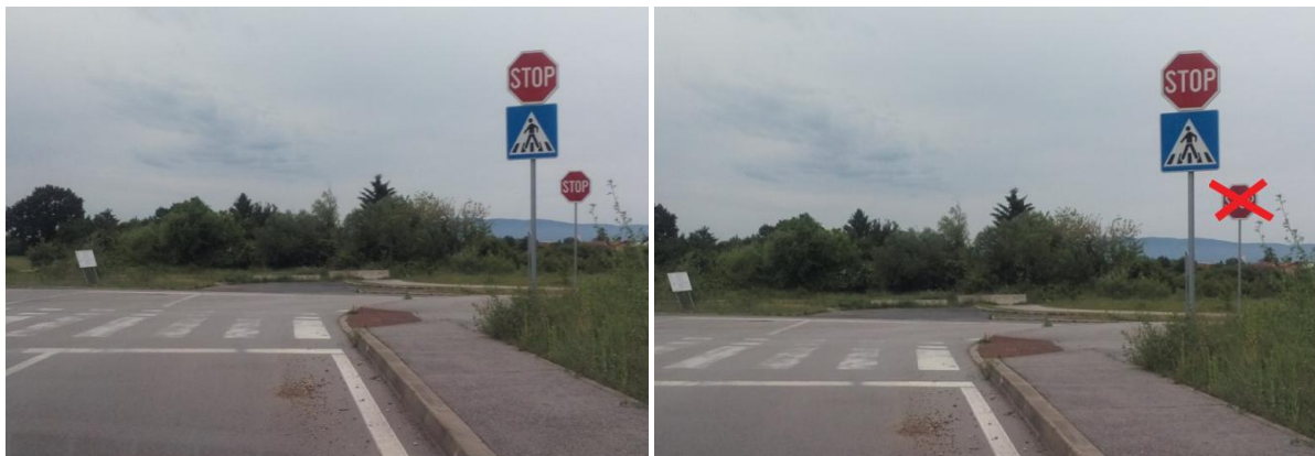
Slika 85. Uklanjanje nepotrebno postavljenog prometnog znaka
