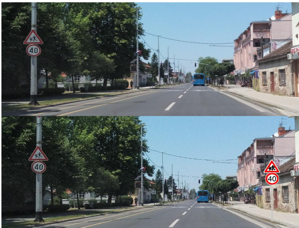
Slika 87. Postavljanje prometnog znaka i s desne strane kolnika
