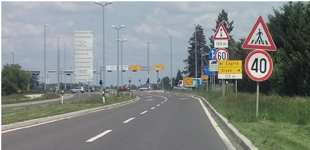
Slika 53. Primjer prometnih znakova kojih je postavljeno previše
