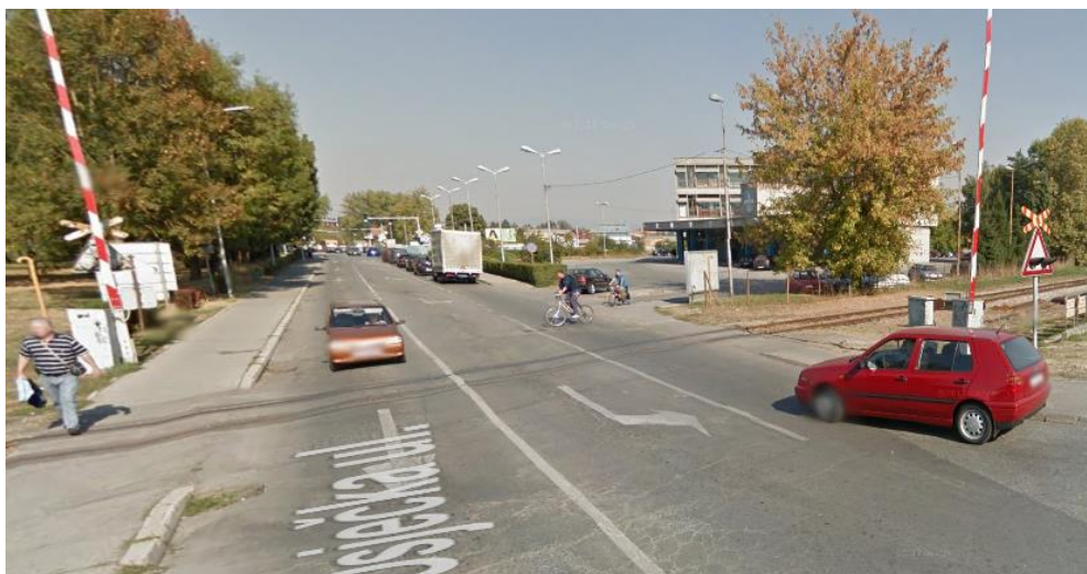
Slika 35. Prikaz cestovno-željezničkog prijelaza na analiziranoj dionici ceste, [5]
