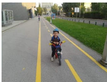
Slika 29. Novoizgrađena biciklistička prometnica, Marohnićeva ulica
