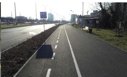
Slika 30. Novoizgrađena biciklistička prometnica, Branimirova ulica
