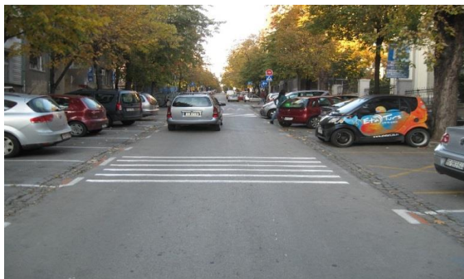
Slika 22. Poprečne vibrirajuće zvučne trake
