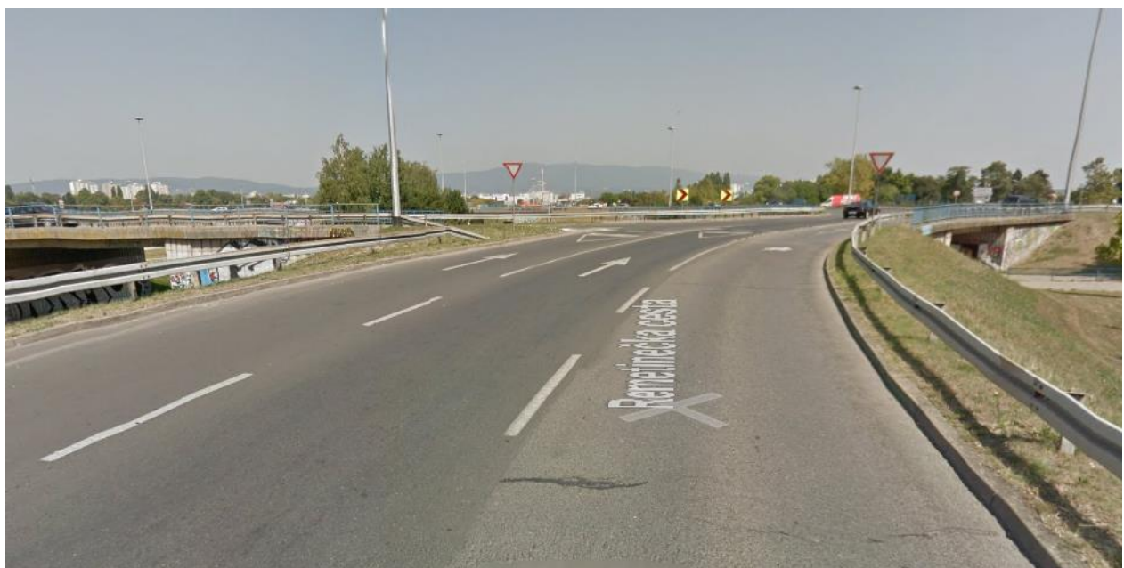
Slika 4.: Postojeće stanje na južnom privozu Remetinečke ceste [5]
