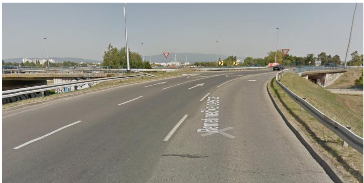
Slika 4.: Postojeće stanje na južnom privozu Remetinečke ceste [5]
