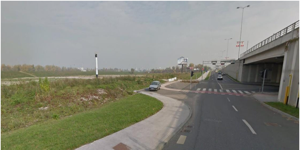
Slika 7.: Postojeće stanje na kojem je predviđena izgradnja mosta, iz smjera Laništa [5]
