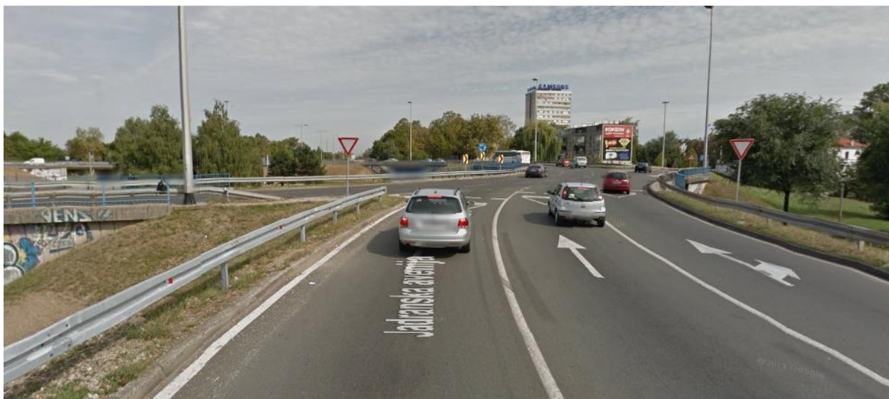
Slika 6.: Postojeće stanje na zapadnom privozu Jadranske avenije [5]
