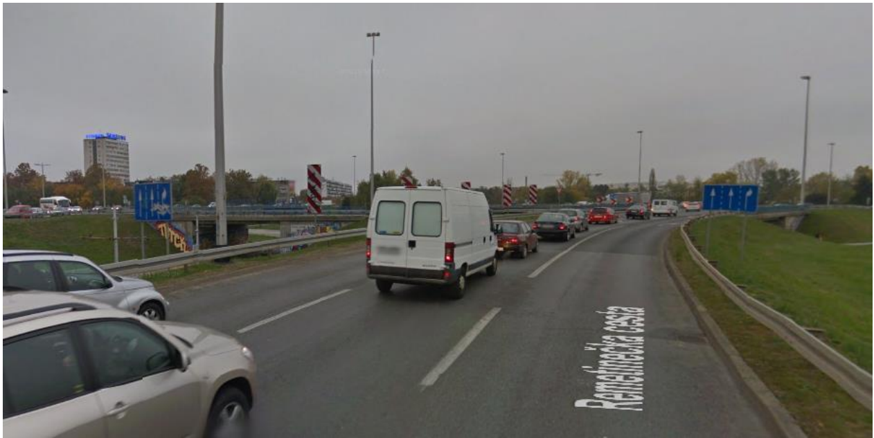
Slika 3.: Postojeće stanje na sjevernom privozu sa Jadranskog mosta [5]
