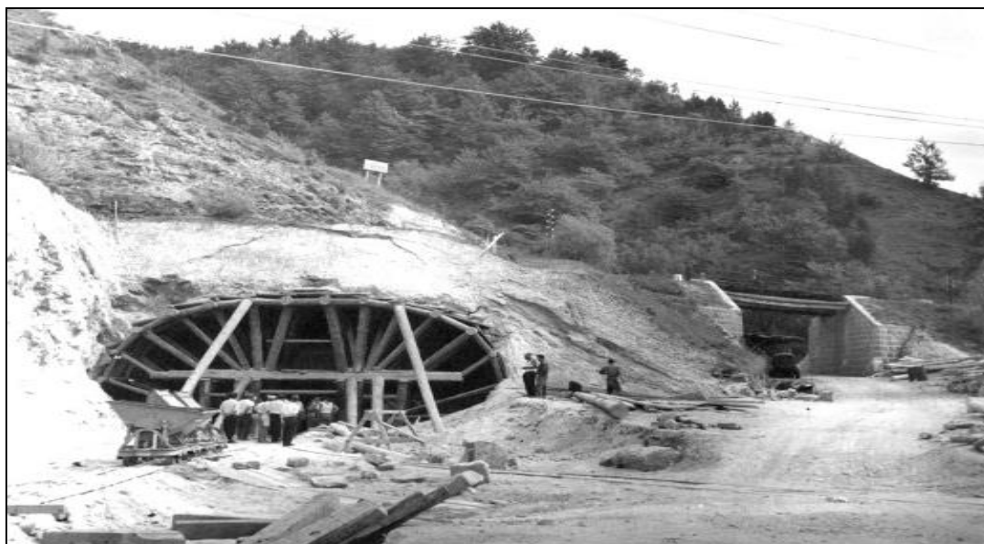
Slika 13. Prikaz izgradnje tunela Donja Dobra na novoj Luizijani
