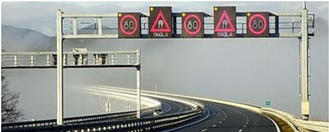
Slika 30. VSL za kontrolu vremenskih uvjeta [Izvor: http://www.telegra-europe.com ]
