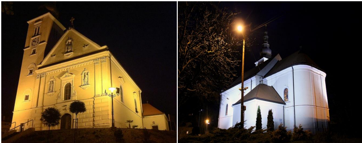
Slika 21. Crkva sv. Nikole prije i poslije rekonstrukcije, [16]
