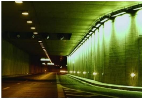
Slika 10. Unutarnja zona tunela,[11]
