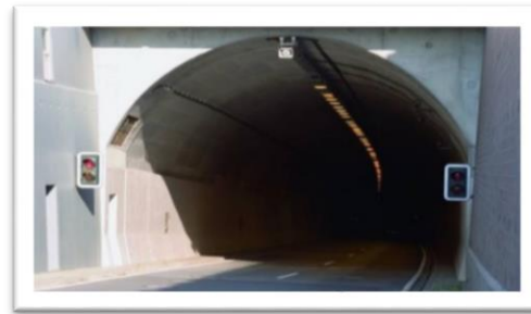
Slika 11. Izlazna zona tunela, [11]
