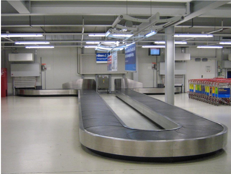
Slika 4.21. Sustav za podizanje prtljage tipa karusel, [17]
