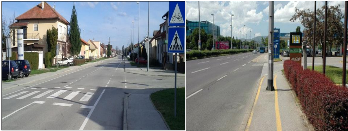
Slika 11. Nepravilno obilježavanje i objekti smetnje
