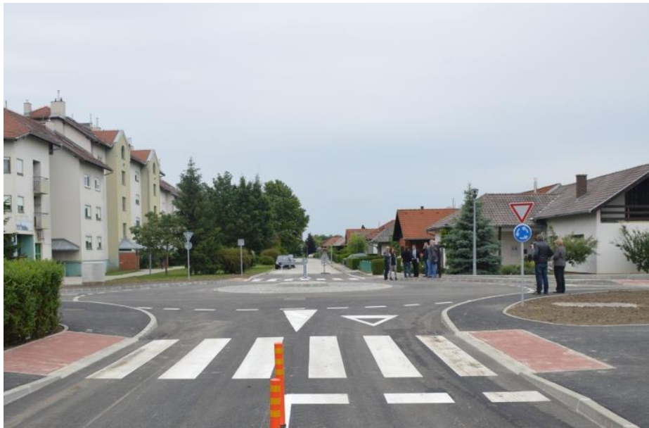
Slika 14. Opasno mjesto Čakovec, Tomaša Goričanca - Ivana Sokača nakon sanacije Izvor: [13]
