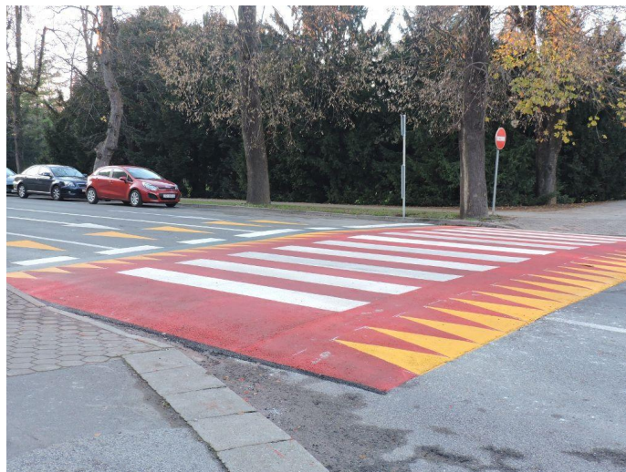
Slika 18. Uzdignuta ploha s pješačkim prijelazom u Varaždinu [19]
