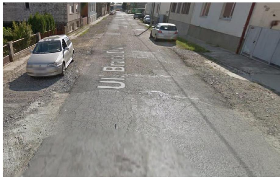
**Slika 22.** Oštećenje kolnika u Ulici Braće Radić u Bjelovaru [20]
