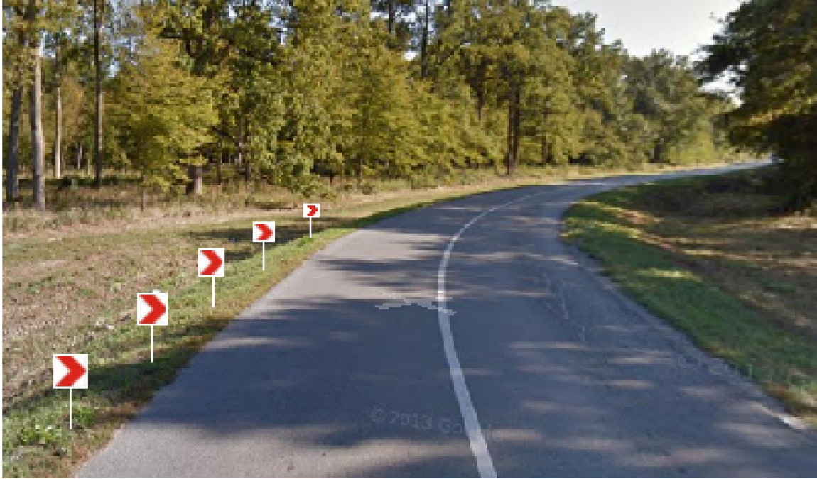
Slika 14. Prijedlog sanacije opasnog mjesta u Ulici Ivana Mažuranića u Ivanskoj Izvor: [19]
