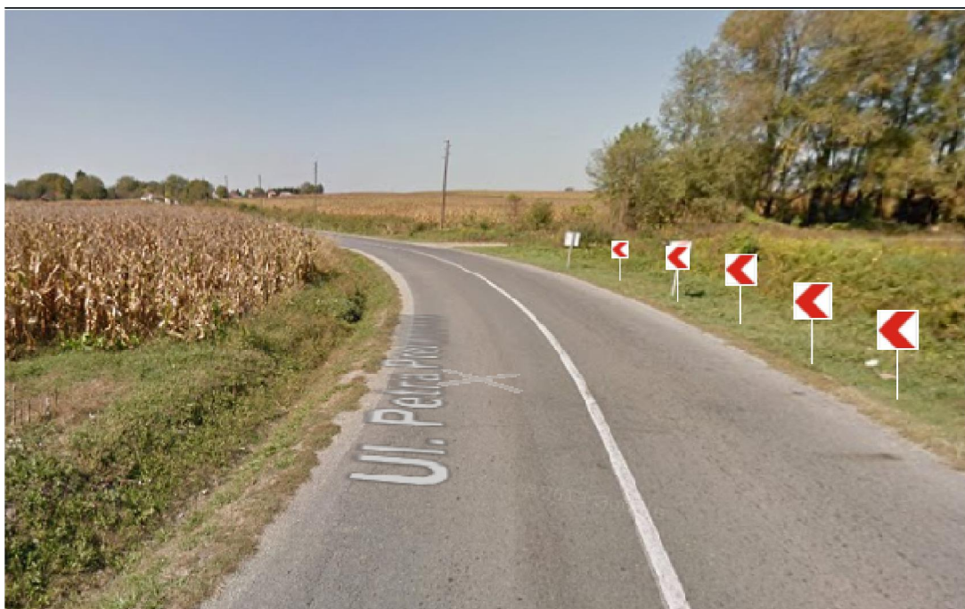
Slika 15. Prijedlog sanacije opasnog mjesta u Ulici Petra Preradovića u Velikom Grđevcu Izvor: [19]
