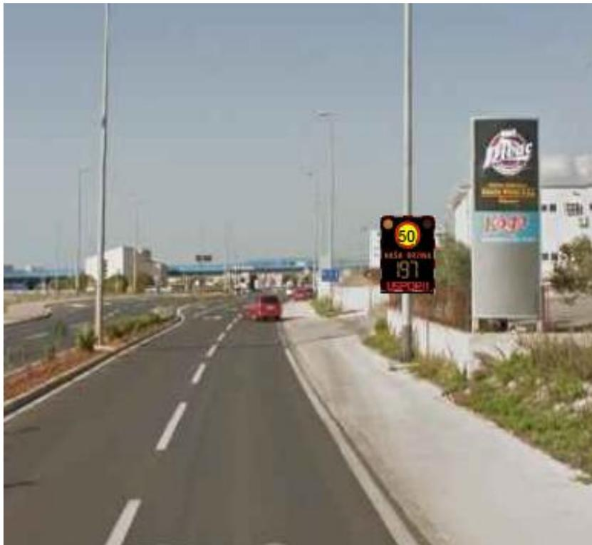
**Slika 14.** Prijedlog rješenja sa radarskim pokazivačem brzine
