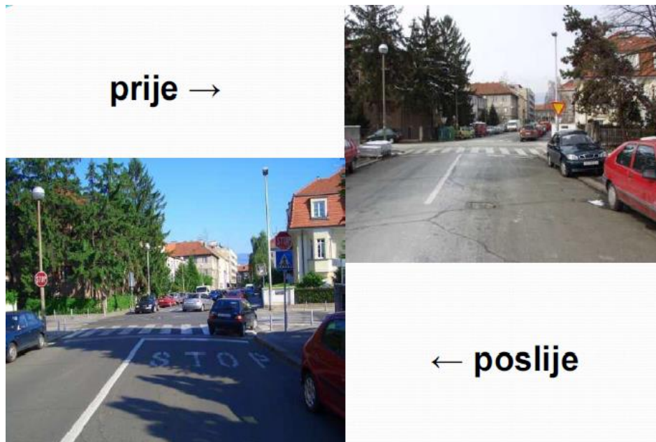
Slika 50. Prikaz sanacije opasnog mjesta zamjenom prometne signalizacije [23]
