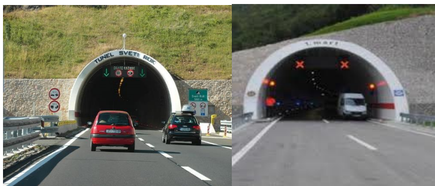
Slika 46. Promjenljivi prometni znakovi za vođenje prometa u tunelima [22]
