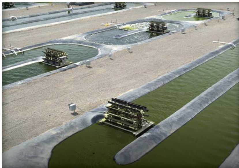
Slika 8. Bazeni sa algama za proizvodnju biogoriva
