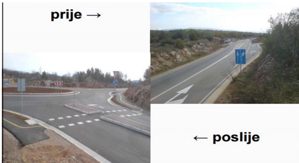
Slika 10. Primjer dugoročne sanacije ceste
