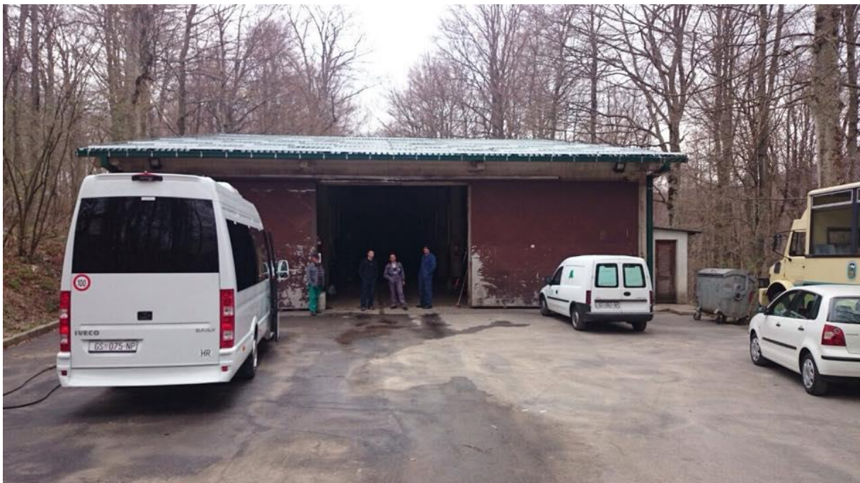
Slika 9. Servisna garaža na Mukinjama
