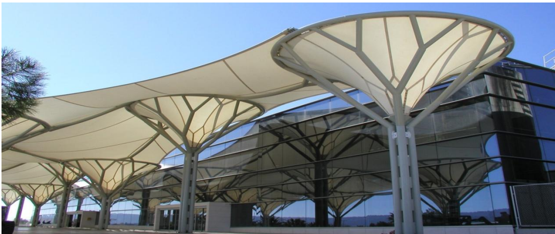
Slika 4.1. Vanjski izgled putničkog terminala ZLS
