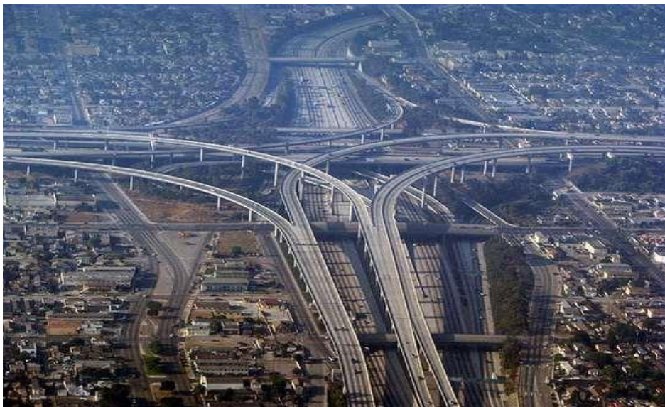
Slika 8. Cestovno čvorište u više razina u Los Angelesu
