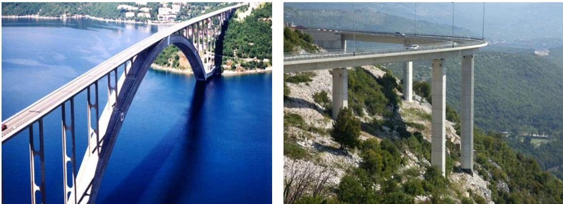
**Slika 9. Razlika između mosta (lijevo) i vijadukta (desno)**
