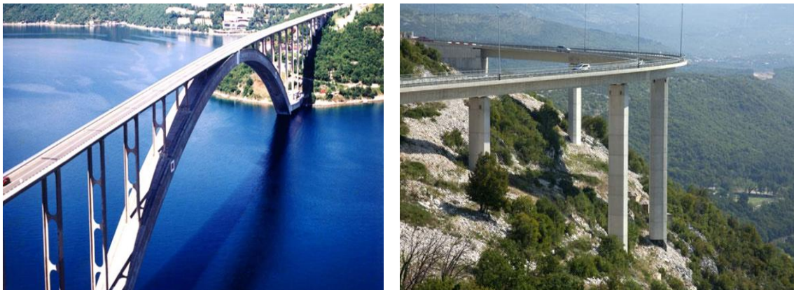
Slika 9. Razlika između mosta (lijevo) i vijadukta (desno)
