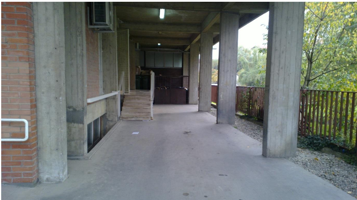
Slika 8: Utovarno-istovarna rampa i stražnji ulaz za radnike PU 10370
