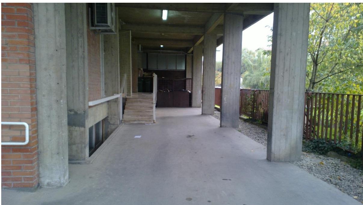
Slika 8: Utovarno-istovarna rampa i stražnji ulaz za radnike PU 10370
