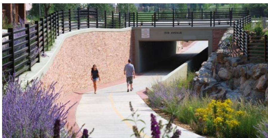
Slika 11. Primjer pothodnika u Boulder, Colorado, USA [24]
