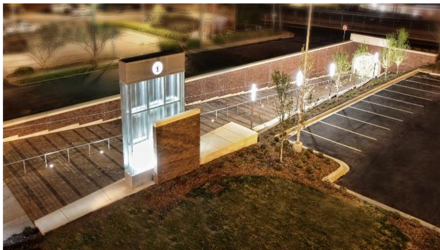
Slika 10. Primjer pothodnika Greensboro, North Carolina, USA [23]
