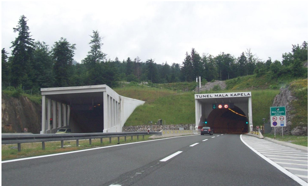
Slika 19. Tunel Mala Kapela, Izvor: [9.]
