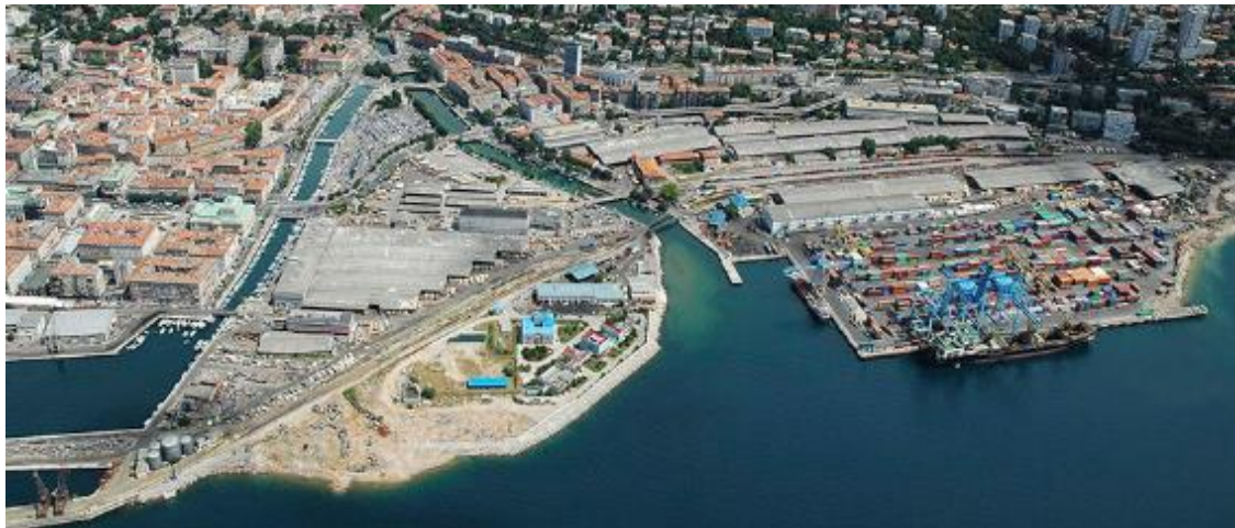
Slika 16. Kontejnerski terminal Brajdica
