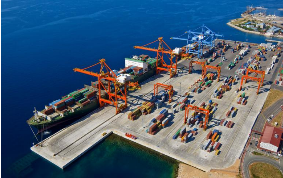
Slika 7. AGCT kontejnerski terminal na Brajdici
