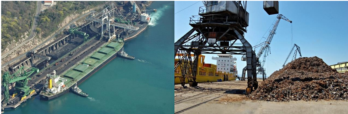
Slika 5. Terminal za rasute terete
