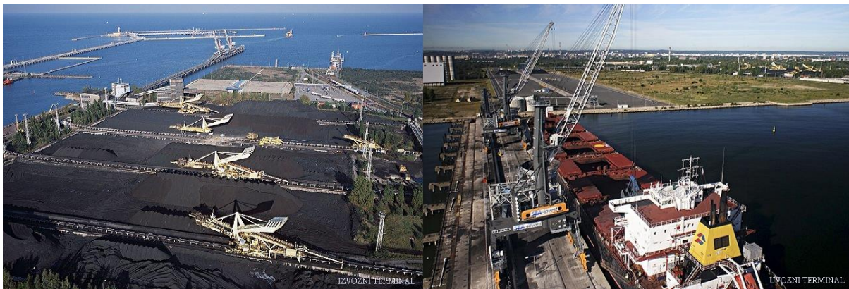
Slika 27. Terminal za suhe rasute terete
